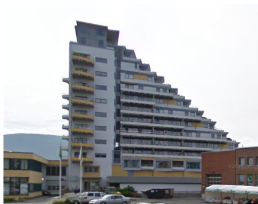
Figur 54. Eksisterende høyhus, leilighetsbygget «kornsiloen»
