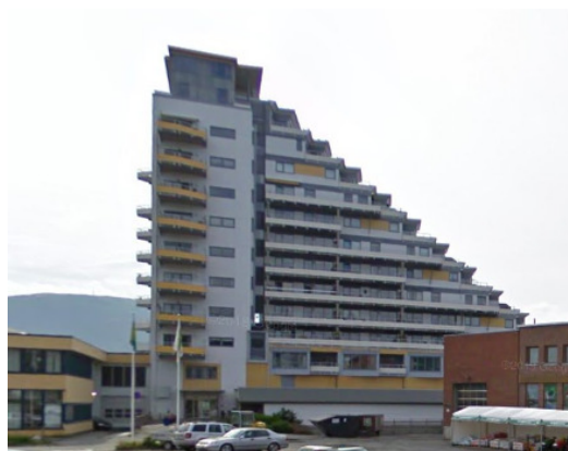
Figur 54. Eksisterende høyhus, leilighetsbygget «kornsiloen»
