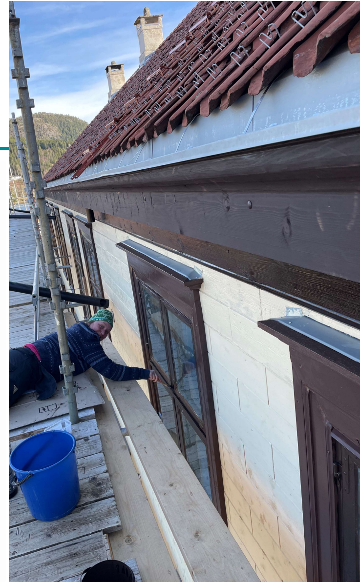
Åsnes glassverk under istandsetting, foto Svestad/ TRFK
