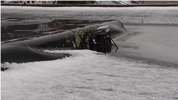
Figur 25: Gamle sluker/varmekabler
