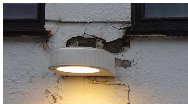
Figur 21: Lokale pusskader
