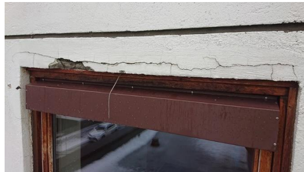
Figur 15: Betongskader i bæring over vinduer
