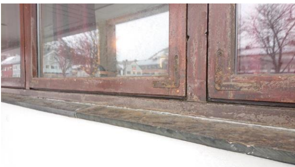
Figur 19: Gamle vinduer, delvis fra byggeår
