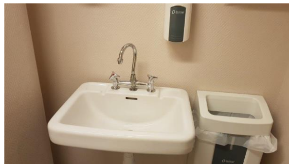
Figur 33: Gamle to-greps servanter/batteri
