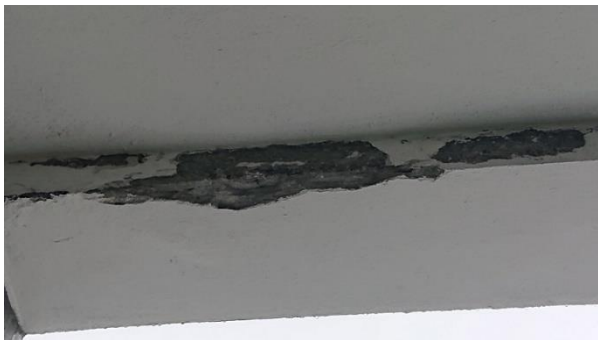
Figur 12: Forvitring utvendig bærebjelker
