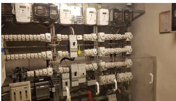
Figur 36: Gammel hovedtavle, fordelinger og skrusikringer
