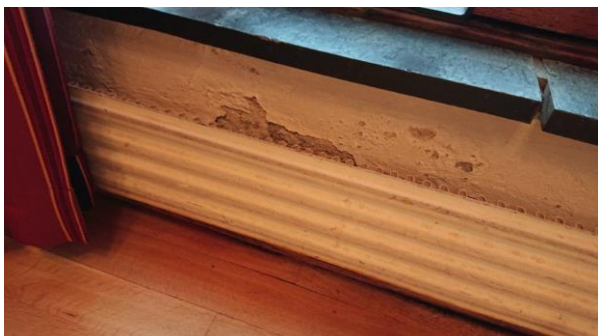
Figur 34: Gamle radiatorer, manglende behovsstyring
