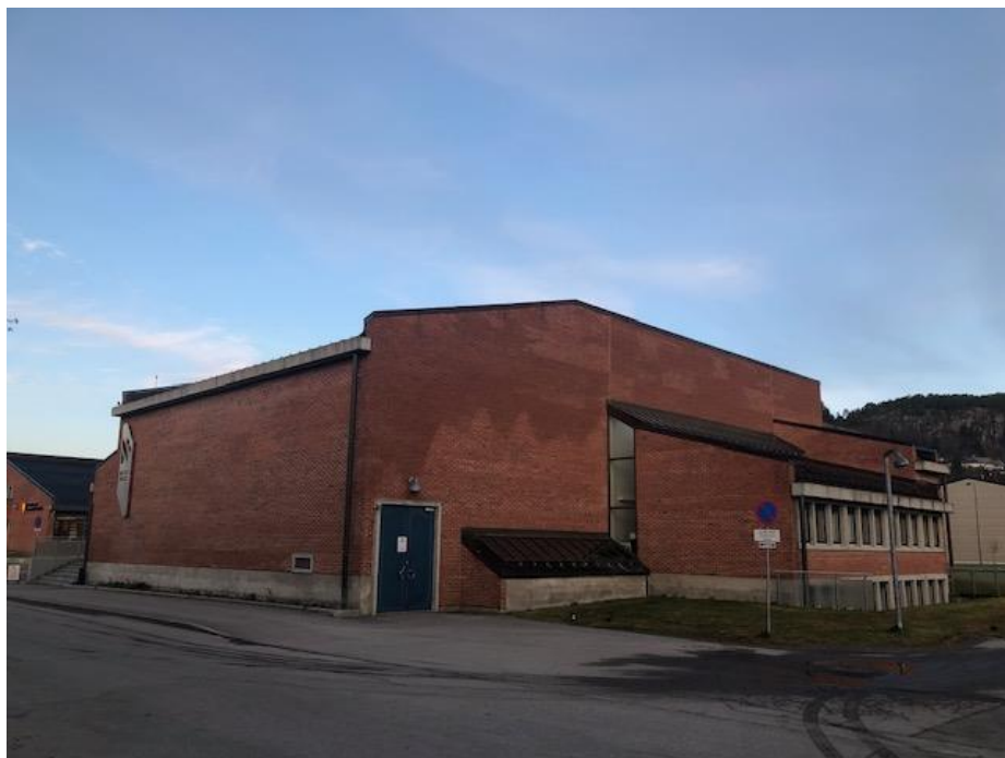
Bilde 6: Kulturhuset fra Stasjonsgata, sydøstre hjørne, konsertsalen med vareinntak til scenen
