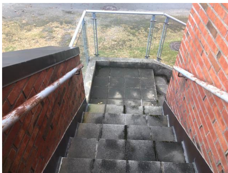
Bilde 15: Utvendig rømningstrapp fra bibliotekfløy
