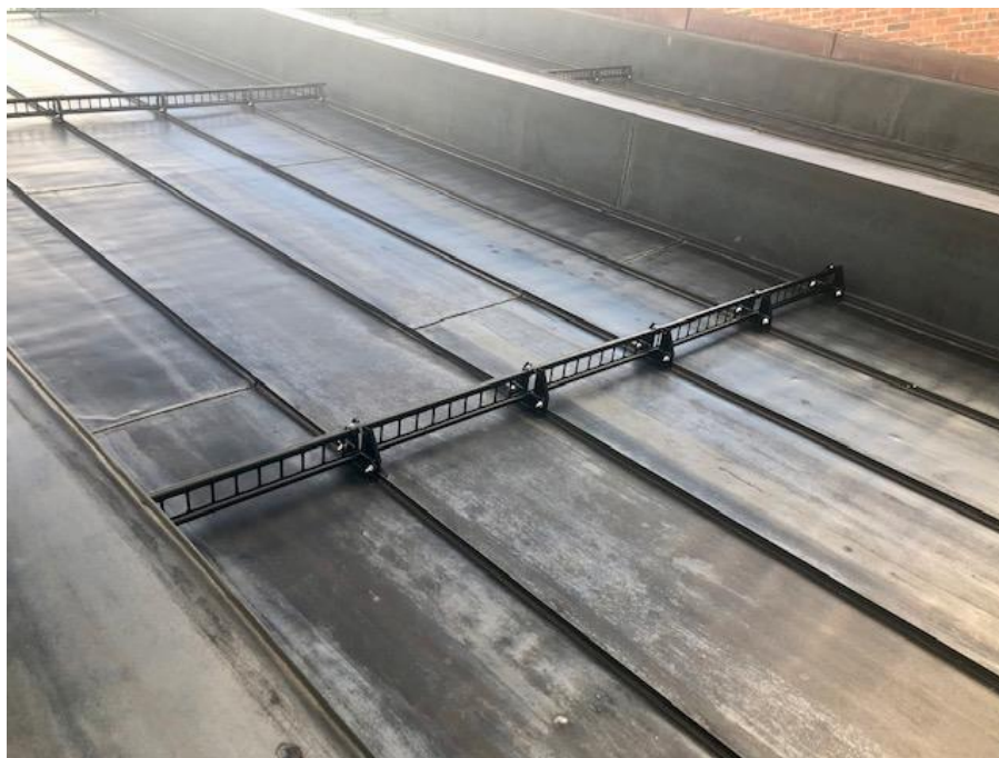
Bilde 9: Ny type snøfangere, innfesting i stangfalsler
