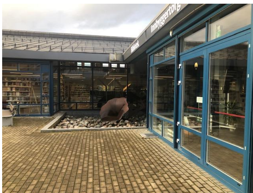
Bilde 21: Basseng i atrium med taknedløp for hoveddelen av taket
