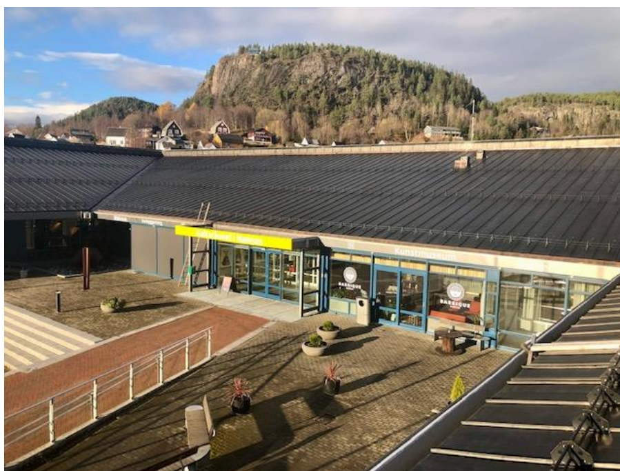
Bilde 2: Taket og atriet med hovedinngang
