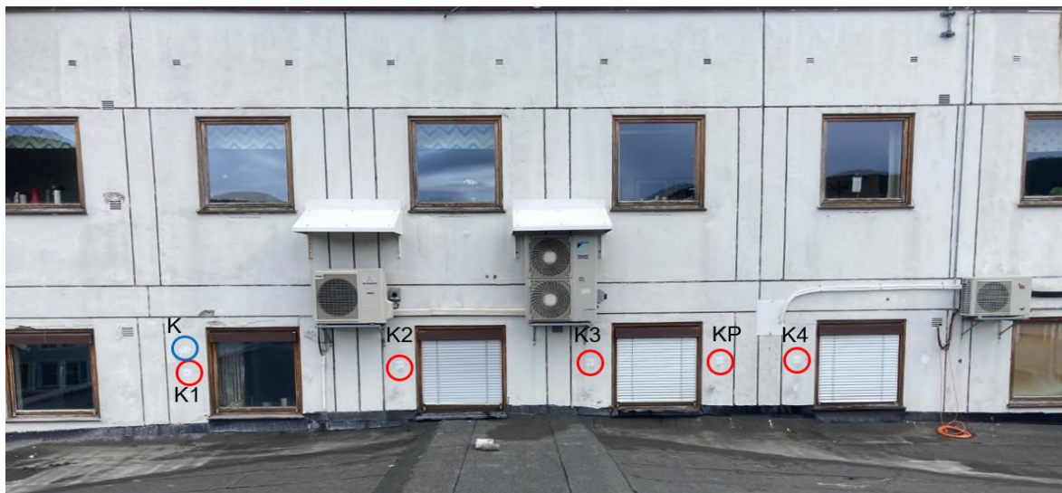
Bilde 1 Vestsiden av kontorfløyen med plassering av kjerneuttaket.
