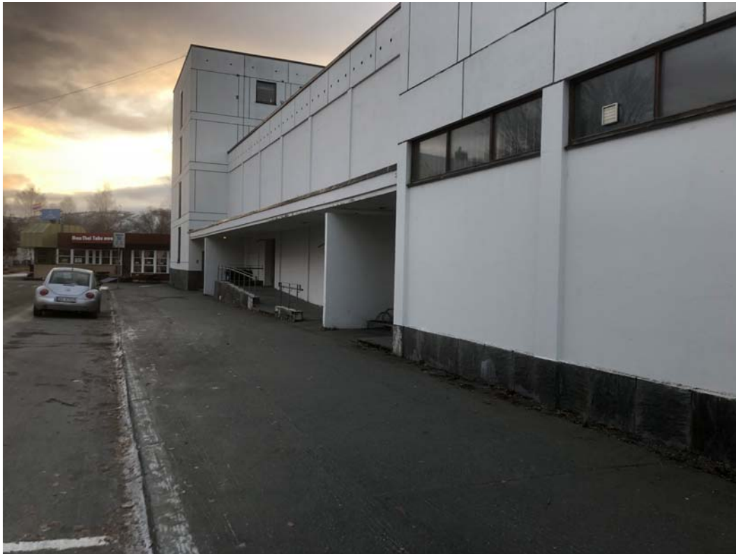
Nordfasaden. Mellombyggets tette betongvegg mot nord byttes ut med vindusfasade.
