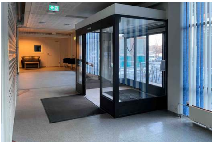
Inngangen til kontorfløya med nytt vindfang og rampe.
