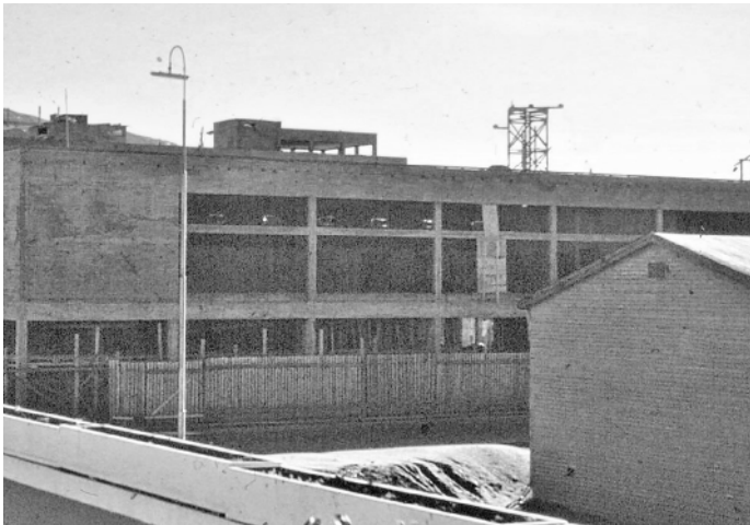
Foto frå konstruksjonen av huset. Foto: Røthe 141
