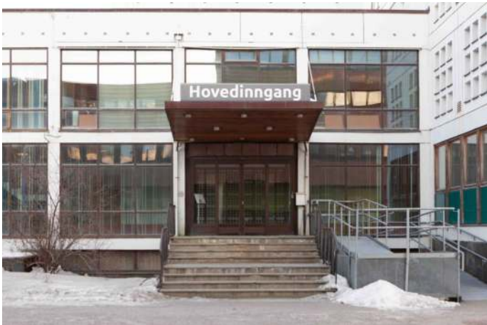
Hovudinngangen på sørsida, med rampe på høgresida.
