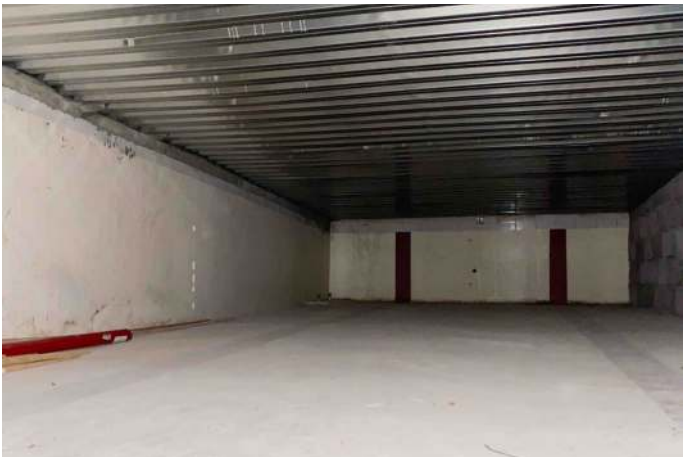
Bassenget er framleis intakt og ein kan sjå det frå ei inspeksjonsluke i den gamle resepsjonen.
