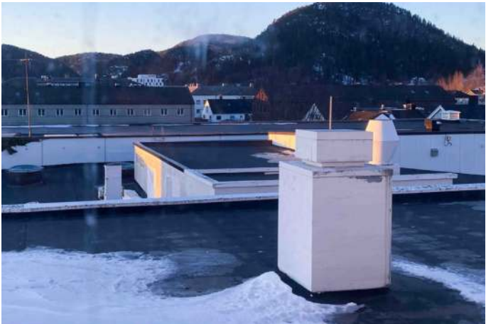
Taklandskapet sett frå taket av kontorfløya.
