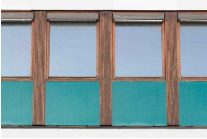
Vindauga i austfasaden med solskjerminga montert rett på ramma.
