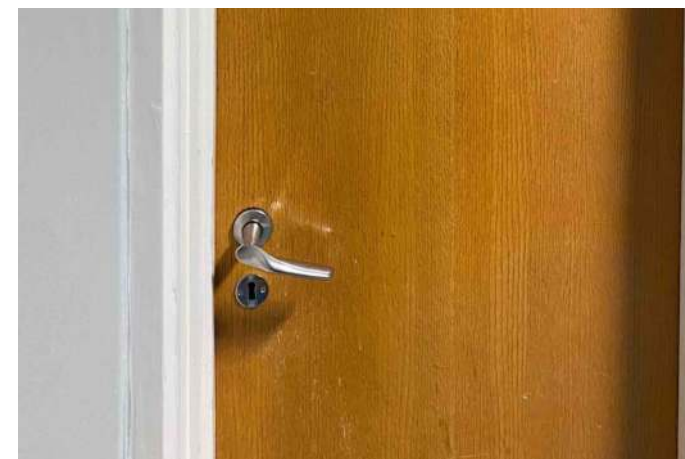
Ei av mange innerdører i huset.
