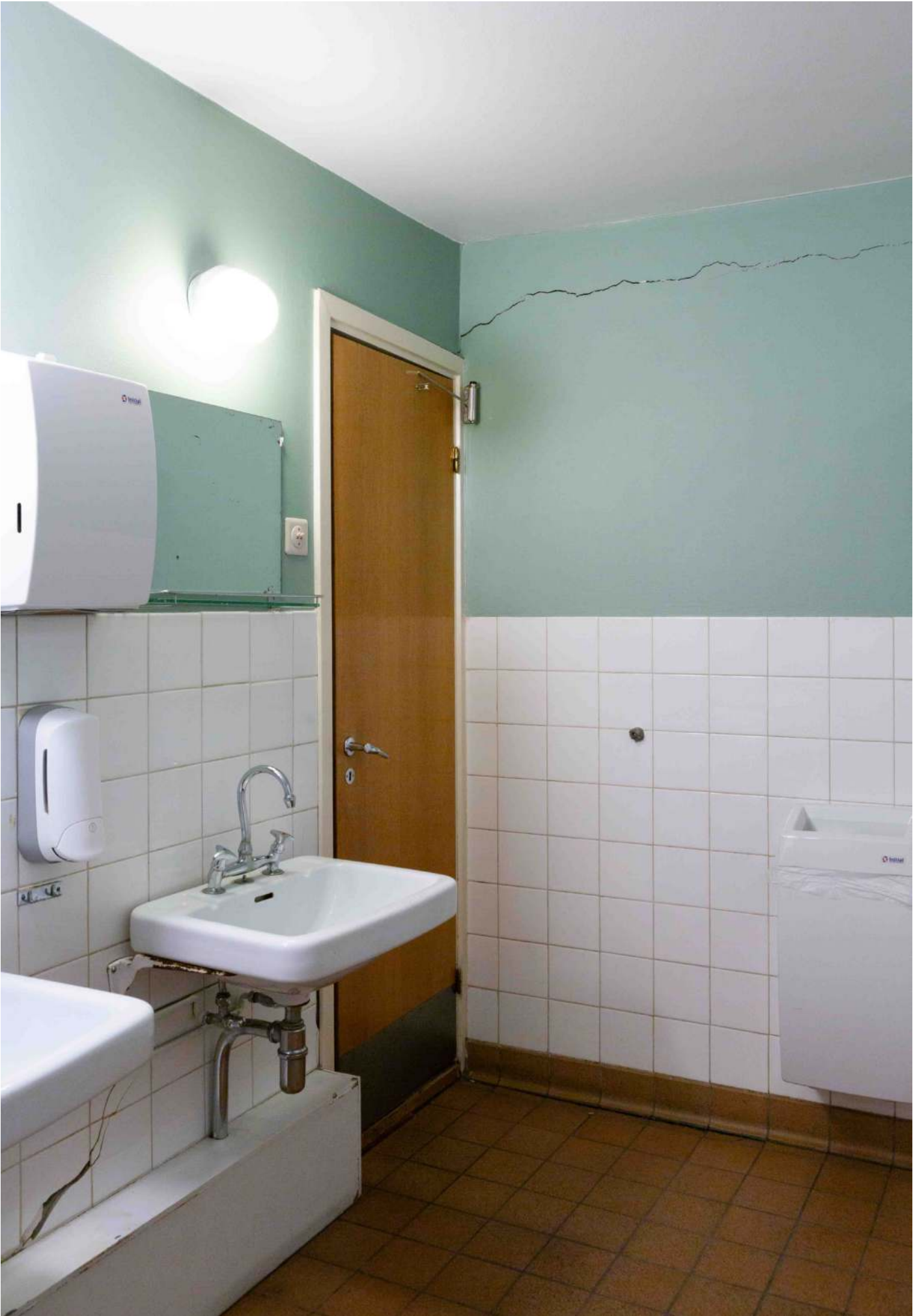
Tydeleg betongriss på dametolettet tilknytta foajéen.
