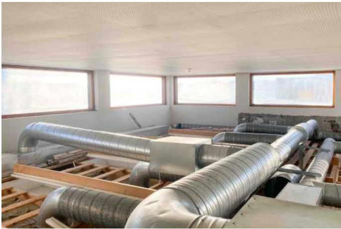
Overlysa finst framleis, men rommet opp er tetta att for å gje plass til ventilasjon.
