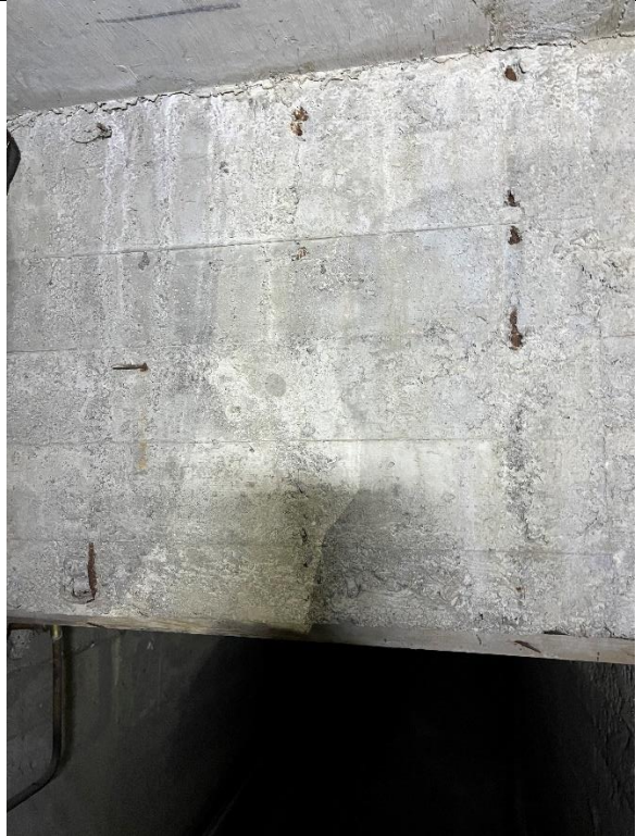
Bilde 31: Synlig armering i drager i krypkjeller.
