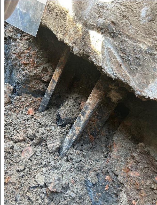
Bilde 20: P 5: Oversikt/plassering av peler.
