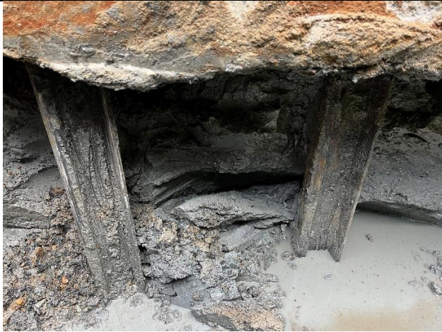
Bilde 2: P 1: Peler før rengjøring.
