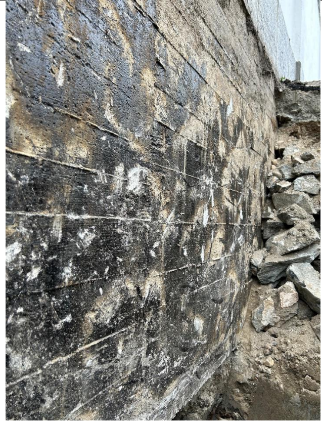
Bilde 11: P 2: Grunnmur uten synlig armeringskorrosjon eller avskallet betong.
