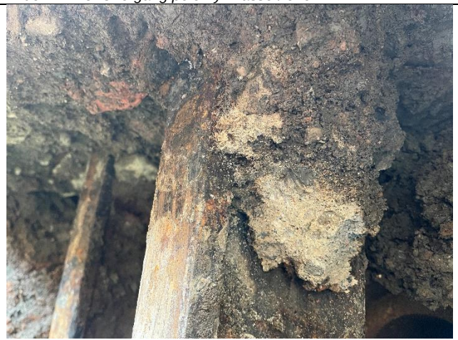
Bilde 21: P 5: Overgang peler fyllmasser/leire.
