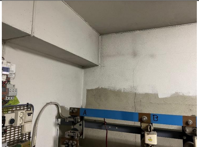
Bilde 35: Traforom riss i yttervegg mot Herlaugsgate, men ingen riss i korridorvegg mot verkstedrom.
