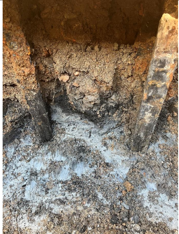
Bilde 21: P 5: Overgang peler fyllmasser/leire.
