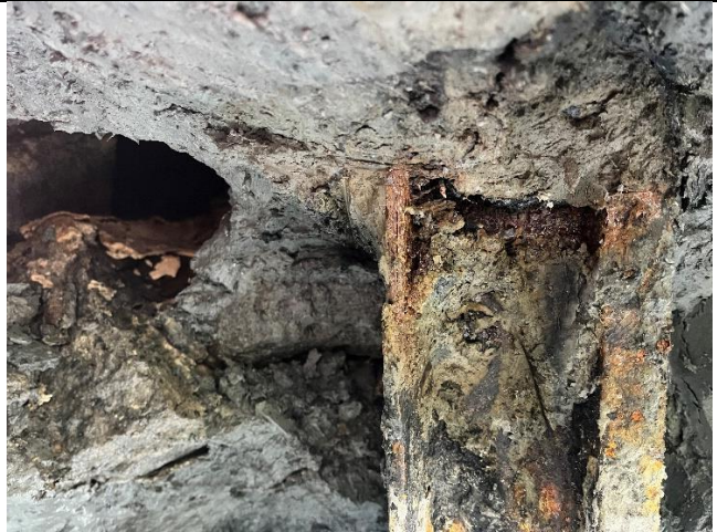
Bilde 3: P 1: Venstre pel i overgang grunnmur.
