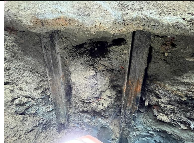
Bilde 12: P 3: Oversikt og plassering av peler.
