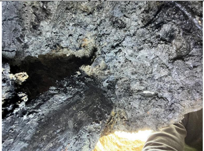
Bilde 3: P 1: Venstre pel i overgang grunnmur.
