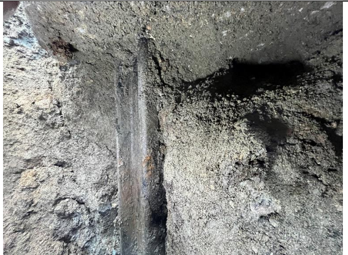
Bilde 13: P 3: Venstre pele overgang i fundament.
