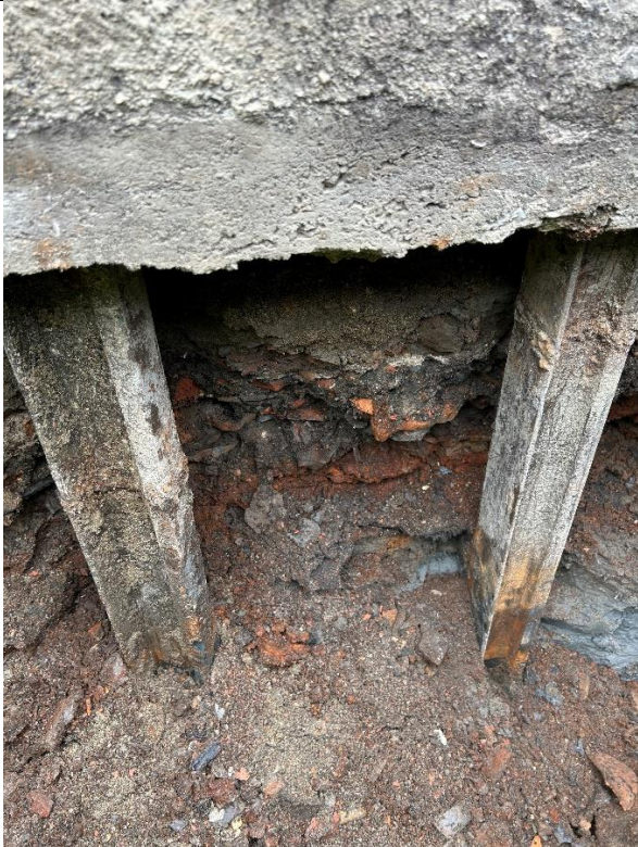
Bilde 6: P 2: oversikt/plassering peler. Mye knust tegl i fyllmasser som danner rød farge på peler.
