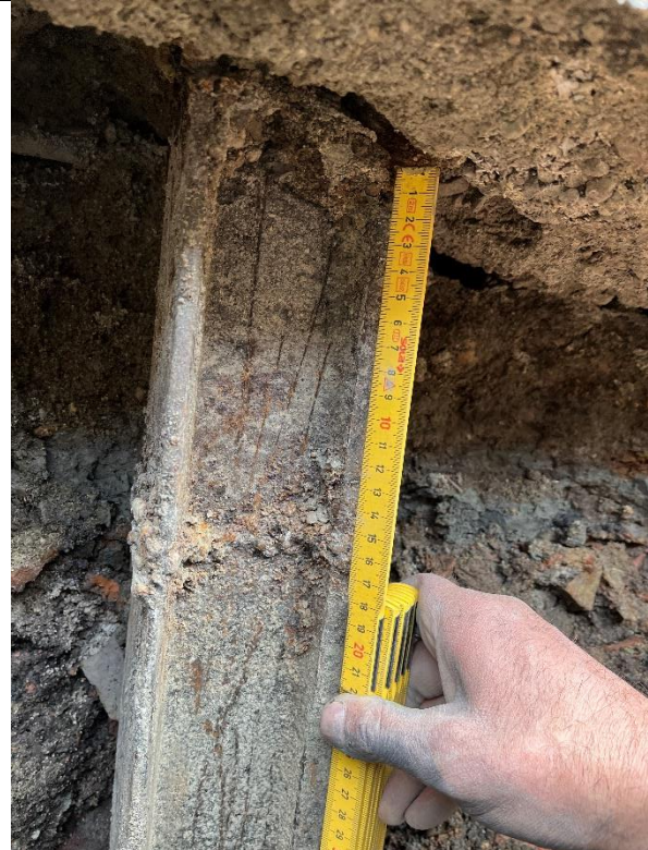
Bilde 7: P 2: Høyre pel ,med overgang i grunnmur og sveiseskjøt.
