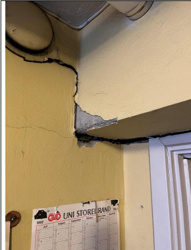
Bilde 26: Sprekk i verksted i kjeller. Sett mot korridorvegg med dørutsparring.
