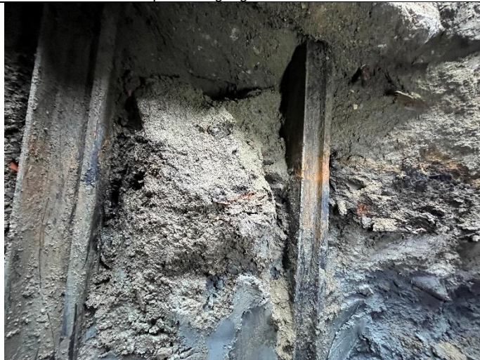
Bilde 13: P 3: Venstre pele overgang i fundament.
