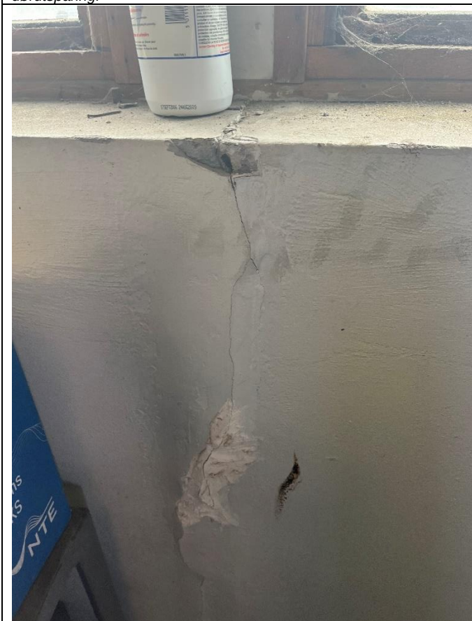
Bilde 26: Sprekk i verksted i kjeller. Sett mot korridorvegg med dørutsparring.
