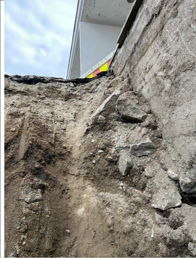
Bilde 10: P 2: fyllmasser med stor stein langs grunnmur.
