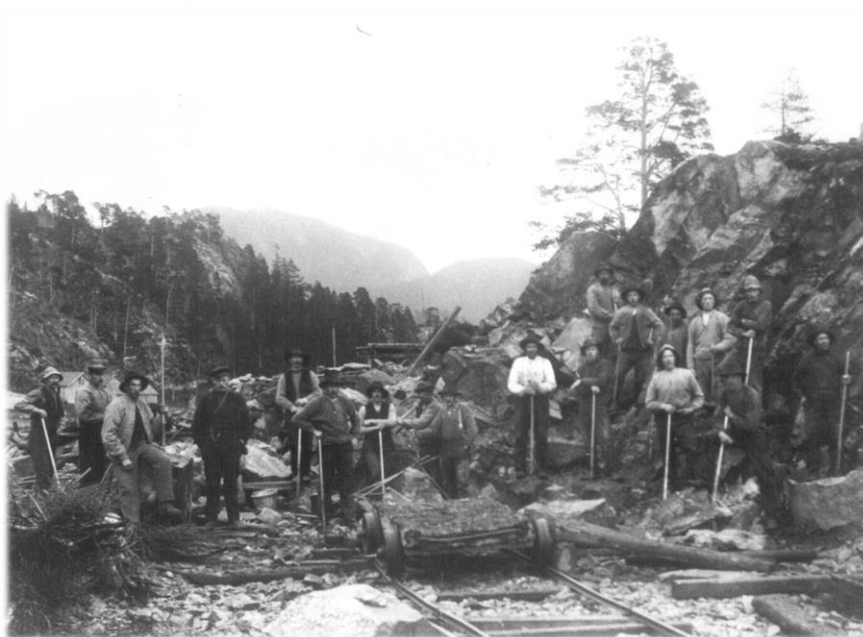
Sannsynligvis et bilde fra byggingen av kraftstasjonen i Tavlåa i 1906/07.
