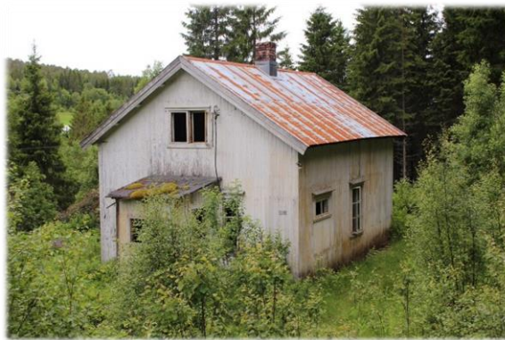
Bestyrerboligen ved Sævik kraftstasjon
