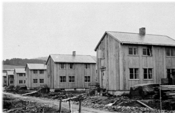
Svenskhusene under oppføring i 1941
