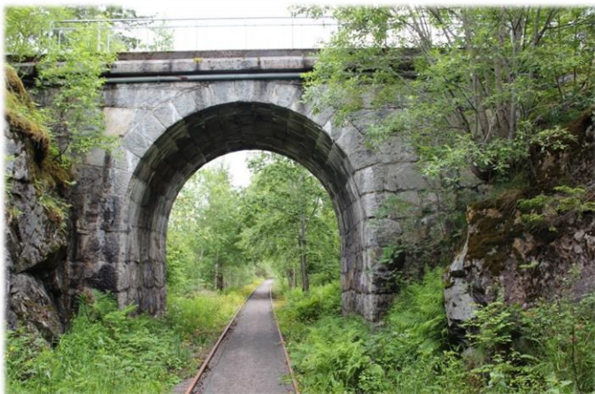
Jernbanetunnel i forlengelsen av Namsenbrua mot nord
