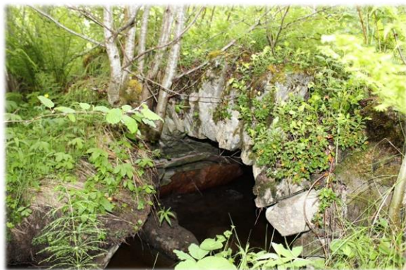
Steinhvelvsbru ved Høyknesvatnet
