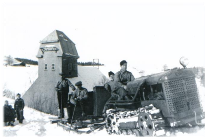
Sævik kraftstasjon i mellomkrigstiden
