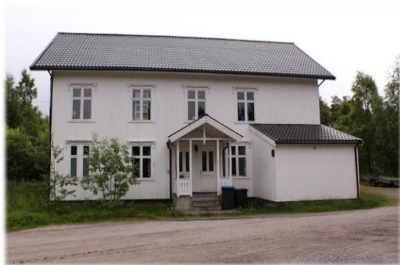
Kontorbygningen ved Bangdalsbruket
