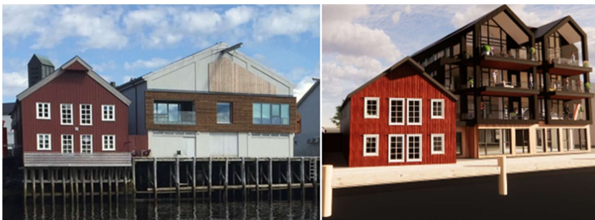
Figur 31. Verftsgata 26 og 28 sett fra sjøen, eksisterende bygning til venstre, ny bygning til høyre
