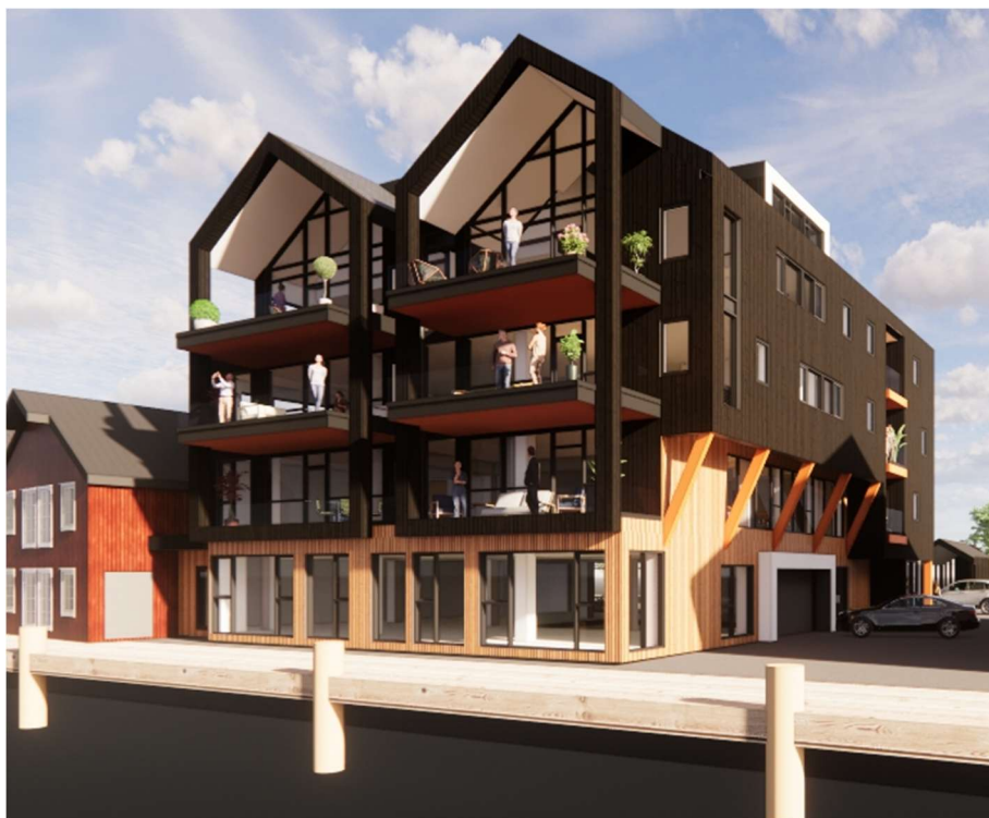
Figur 30. Utspring utenfor betongkonstruksjon vises til høyre i bildet
